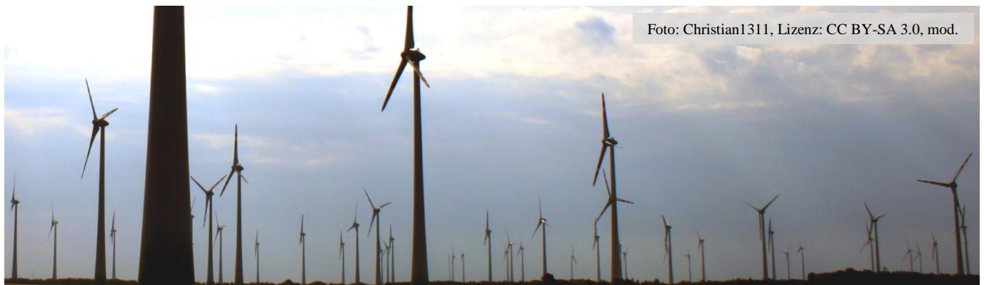
Teilansicht des „Windparks Andau/Halbturm“ im Burgenland. Die Landschaft wird zu einem riesigen Industriegebiet degradiert, das durch optische Emissionen (Anlagen als solche, drehende Rotoren, blinkende Gefahrenfeuer) und akustische Emissionen (Lärm durch Rotordrehung und Generatoren) bestimmt ist.
